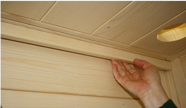
Abb. 38: Einkleben des LED Stripes
