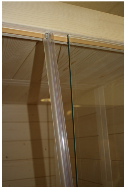
Fig. 20: Colocação da vedação da porta
