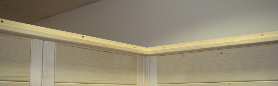
Abb. 17: Einlegen Dachelement hinten mit Lüfterausschnitt
