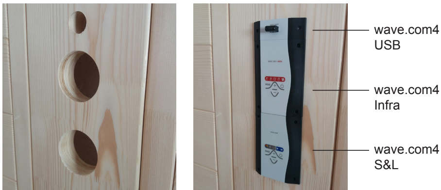
Fig. 49: Montagem da unidade de comando
