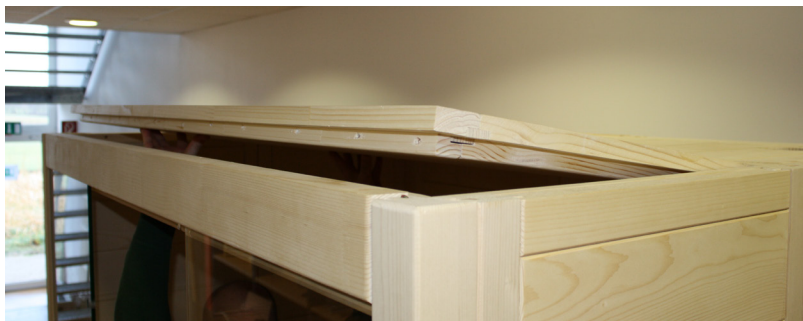
Fig. 18: Inserção dos elementos de teto da frente
