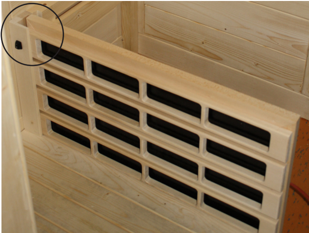
Abb. 34: Einsetzen der IR-Wärmeplatte VitaMy 164
