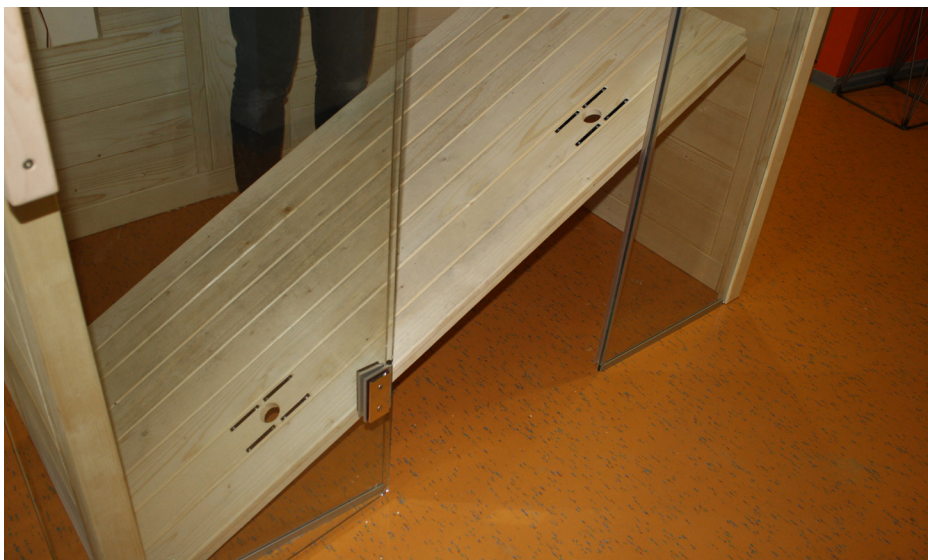
Fig. 28: Inserir o chão da cabina
