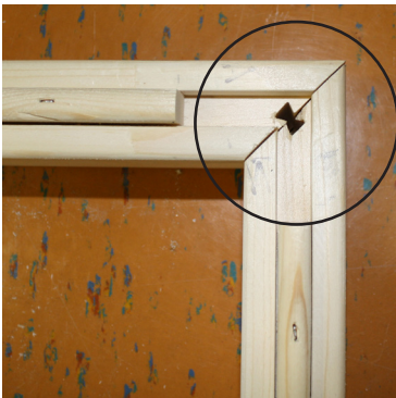
Abb. 2: Bodenelemente verbinden
