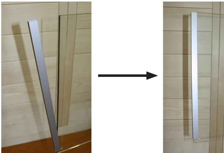
Fig. 11: Instalar os perfis em U nas placas de vidro
