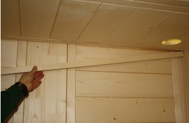
Abb. 37: Montage der LED-Abdeckleiste
