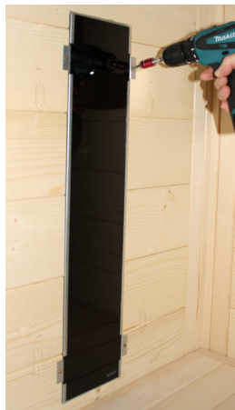
Fig. 41 : Monter le radiateur arrière (radiateur infrarouge ECO 350)
