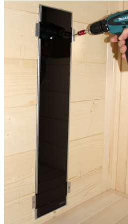
Abb. 41: Rückenstrahler (Infrarot-Strahler ECO 350) montieren
