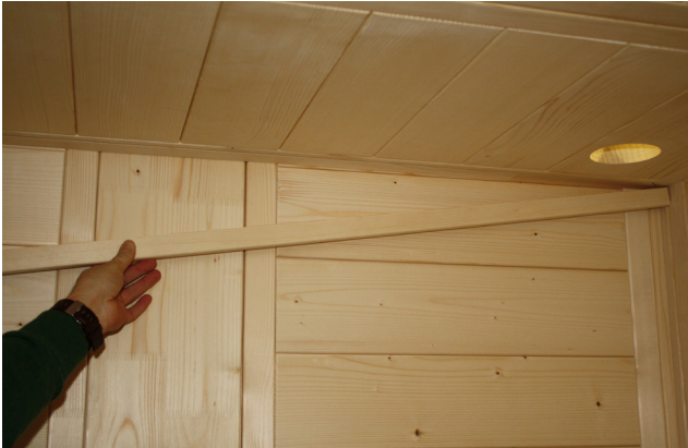
Fig. 37 : Montage de la baguette de recouvrement LED
