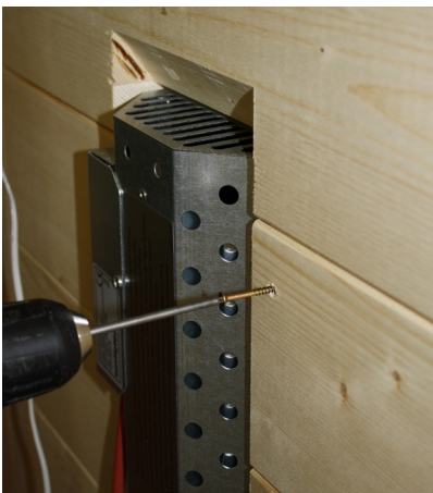
Abb. 42: Blende der Rückenstrahler montieren
