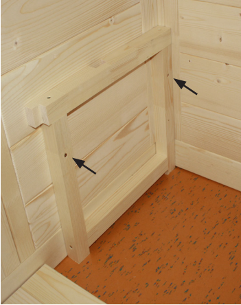
Fig. 32: Montagem do apoio do banco
