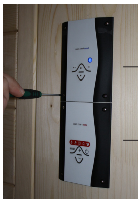
Fig. 46 : Montage de l'élément de commande
