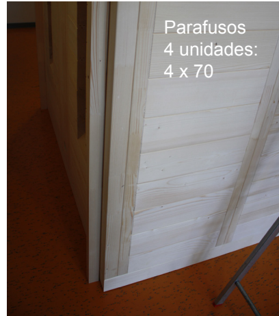
Fig. 52: Montagem das barras distanciadoras na parede traseira
