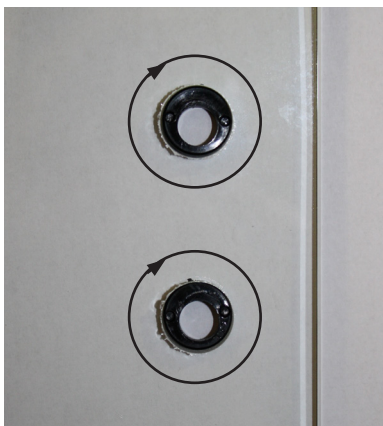
Fig. 22 : Montage des ferrures de portes 1
