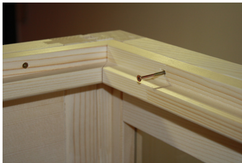
Fig. 14: Montagem das barras de apoio para o teto
