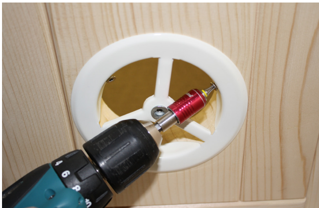
Fig. 36: Montagem da ventilação
