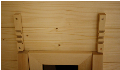
Fig. 54 : Montage des appui-têtes
