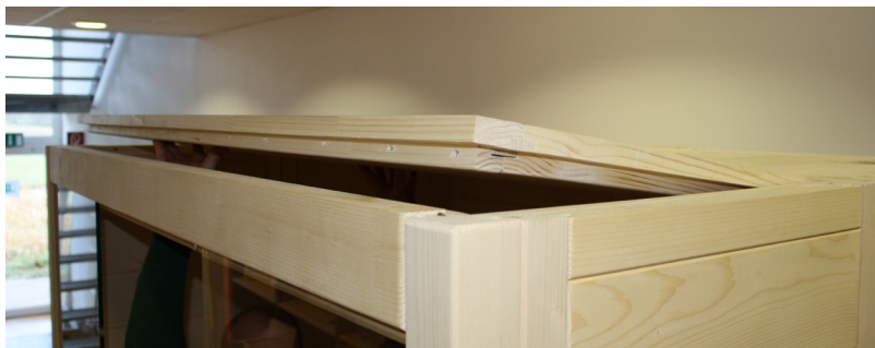
Afb. 18: Plaatsen van dakelementen voorzijde
