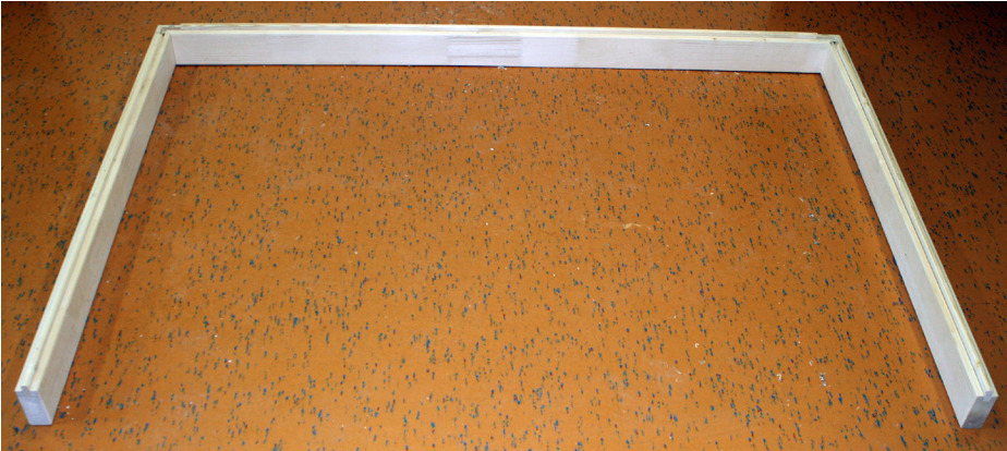
Fig. 1 : Pose des trois éléments de cadre de plancher
