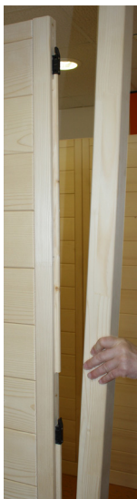
Fig. 9 : Montage des deux montants d'angle avant avec rainure pour verre
