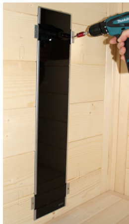
Fig. 41: Montar o radiador traseiro (radiador de infravermelhos ECO 350)
