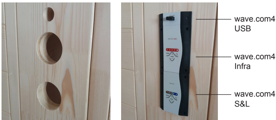
Fig. 49 : Montage du panneau de commande
