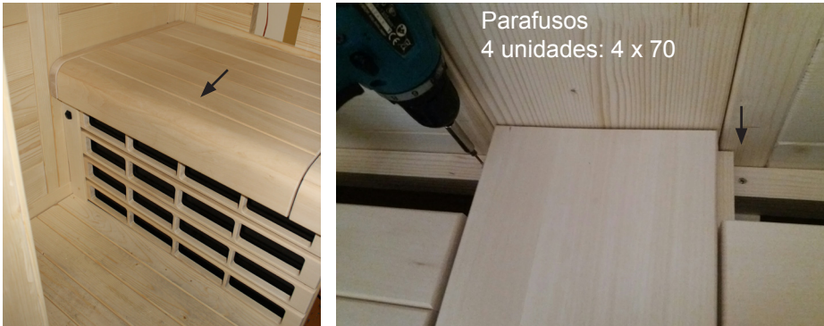
Fig. 51: Fixação do banco
