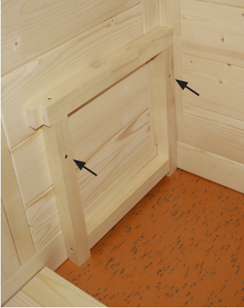
Fig. 32 : Montage du support du banc
