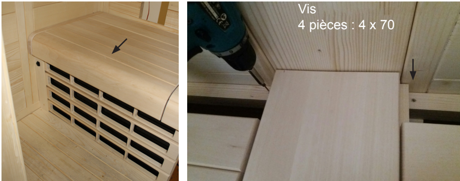
Fig. 51 : Fixation du banc
