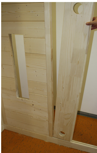
Fig. 6 : Insérer l'élément électrique
