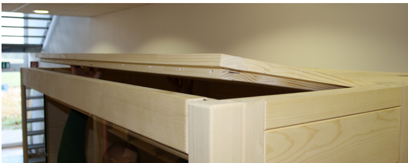
Fig. 18 : Insertion de l'élément de toit avant
