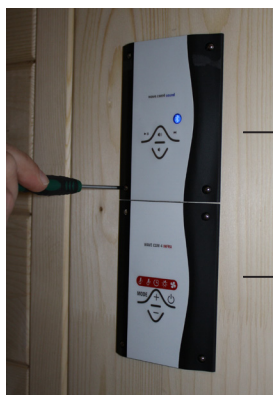
Fig. 46: Montagem da unidade de comando
