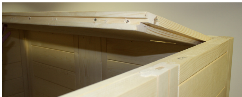
Fig. 18: Inserção dos elementos de teto da frente
