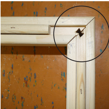
Afb. 2: Bodemelementen verbinden
