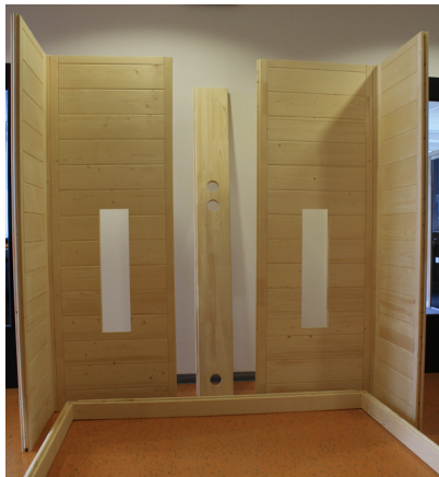
Abb. 5: Montage auf Bodenrahmen
