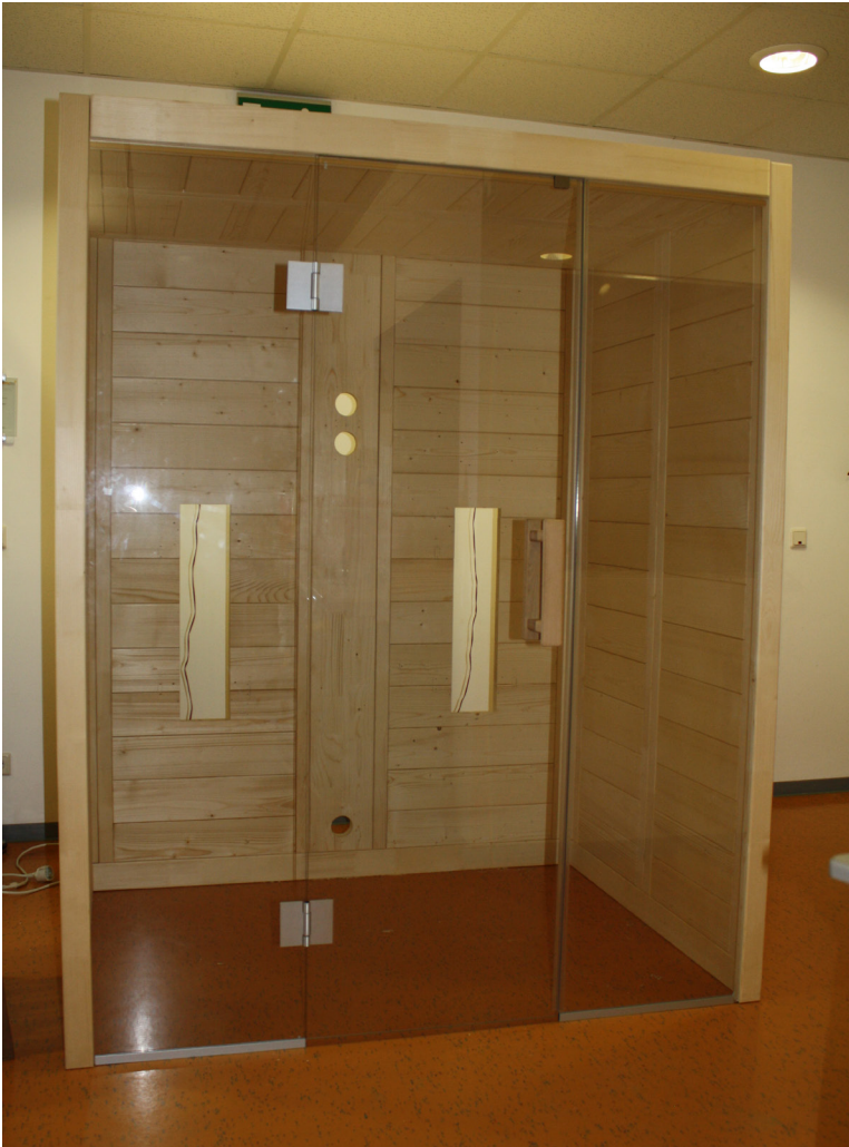
Abb. 26: Fertige Kabinenwände und Dachelemente
