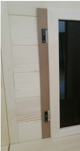
Fig. 53: Montagem dos encostos
