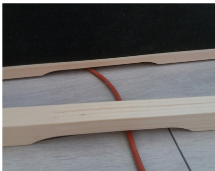
Fig. 35 : Insertion de la bande de renfort pour plaques chauffantes IR VitaMy
