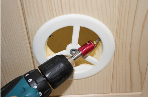
Abb. 36: Montage der Entlüftung
