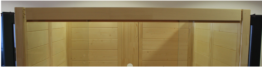
Fig. 15: Fixação da barra maciça
