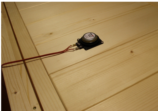
Fig. 47: Montagem do excitador
