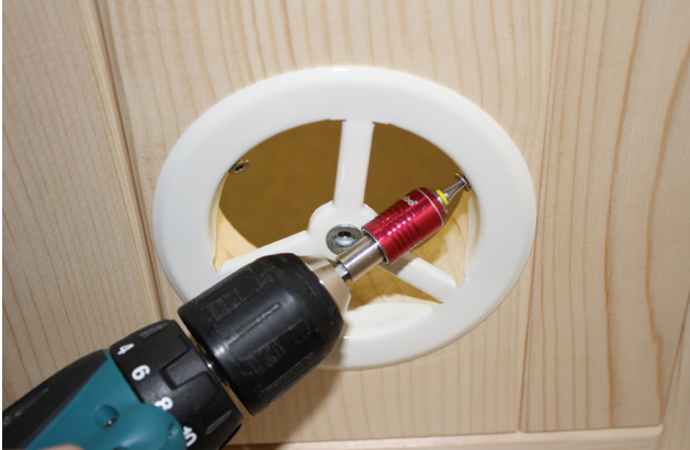
Afb. 36: Montage van de ontluchting
