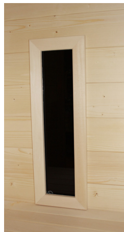
Abb. 42: Blende der Rückenstrahler montieren
