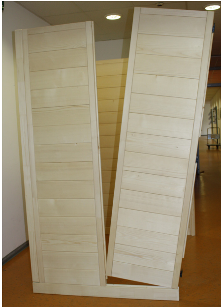
Afb. 9: Montage van de twee voorste hoekstanders met groef voor glas
