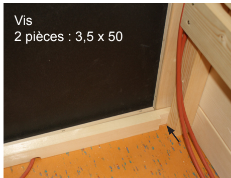
Fig. 35 : Insertion de la bande de renfort pour plaques chauffantes IR VitaMy
