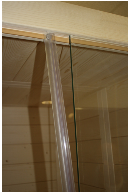
Fig. 20 : Positionnement du joint de la porte
