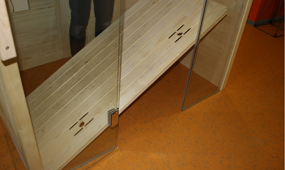
Fig. 28 : Poser le plancher de la cabine
