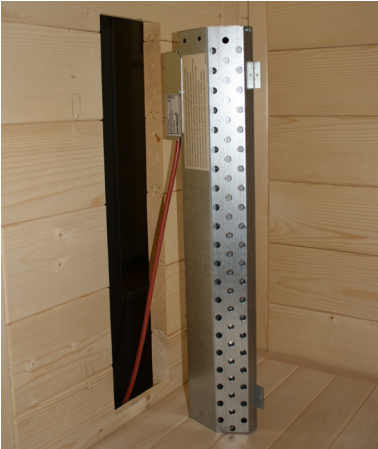
Abb. 41: Rückenstrahler (Infrarot-Strahler ECO 350) montieren
