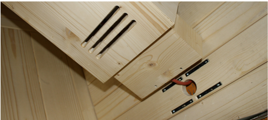
Abb. 29: Frontstrahler fixieren
