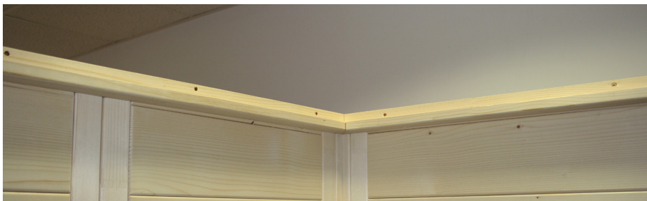
Afb. 17: Plaatsen van dakelement achter met ventilatoruitsparing
