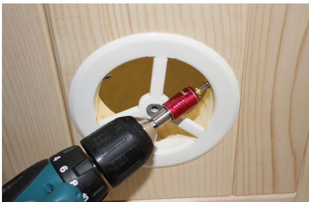
Fig. 36 : Montage de la ventilation
