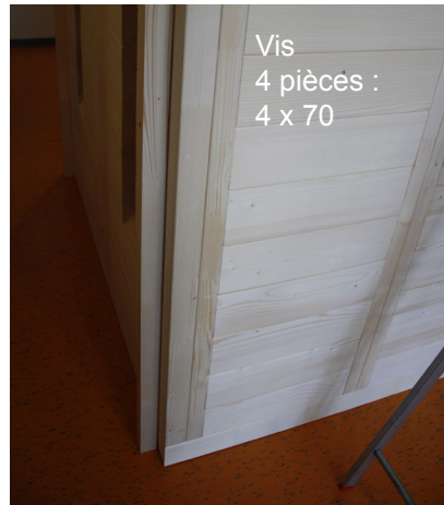
Fig. 52 : Montage des barres d'écartement paroi arrière
