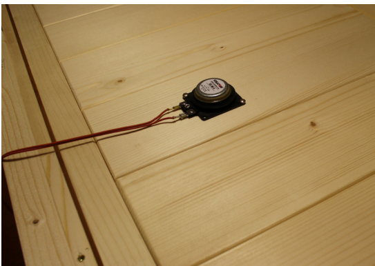
Abb. 47: Montage der Exciter
