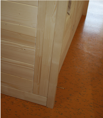
Abb. 52: Montage Abstandleisten Rückwand
